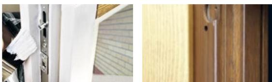
Zum Vorbeugen von Falzverklebungen zwischen Dichtungsband und noch nicht ausgehärteten Dickschichtlasuren bei Fenstern und Türen (sorgt für Blockfestigkeit). **Ergänzende Produkte für die Verarbeitung:** Trikot (S. 22)
